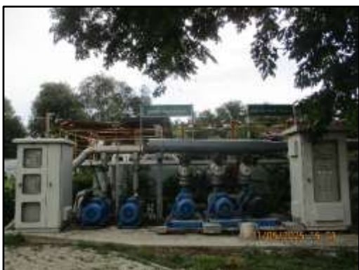
ภาพที่ 2.27 ระบบจ่ายน้ำทิ้ง เครื่องสูบน้ำและท่อส่งน้ำทิ้งภายหลังการบำบัดเพื่อการเกษตร
