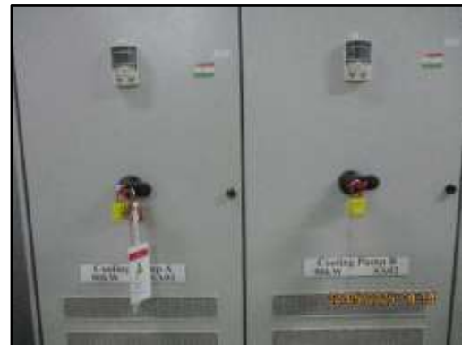
ภาพที่ 2.41 ใส่กุญแจสวิทช์และติดป้ายแจ้ง (Lock out-Tag out)
