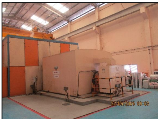
ภาพที่ 3.81 การปิดครอบเครื่องจักรอุปกรณ์ที่มีเสียงดัง
