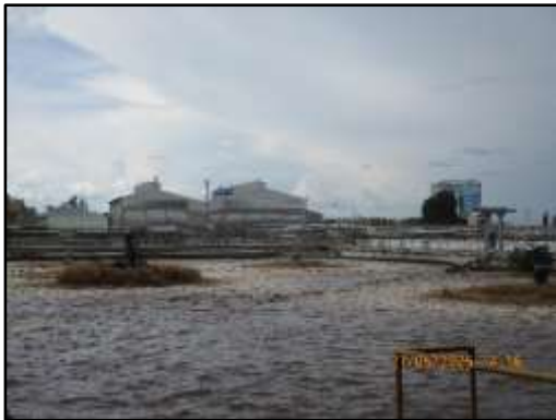
ภาพที่ 2.25 ระบบบำบัดน้ำเสียแบบตะกอนเร่งขนาดการบำบัด 64,100 ลูกบาศก์เมตร/วัน
