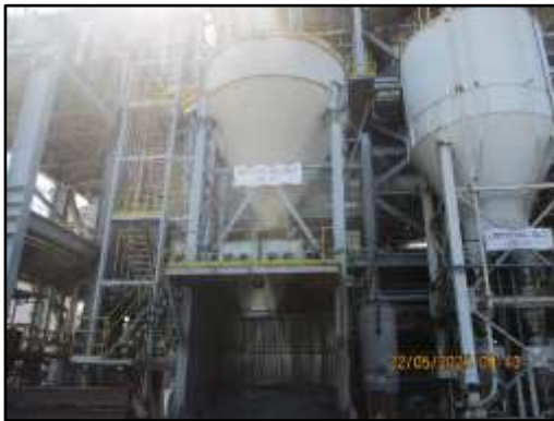
ภาพที่ 2.9 ไซโลกักเก็บเถ้าที่เกิดจากกระบวนการเผาไหม้
