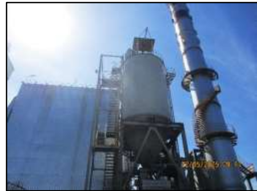
ภาพที่ 2.9 ไซโลกักเก็บเถ้าที่เกิดจากกระบวนการเผาไหม้
