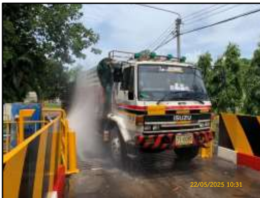
ภาพที่ 2.14 การล้างล้อรถบรรทุกก่อนวิ่งออกนอกโครงการ
