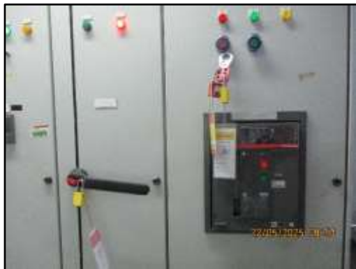
ภาพที่ 2.41 ใส่กุญแจสวิทช์และติดป้ายแจ้ง (Lock out-Tag out)
