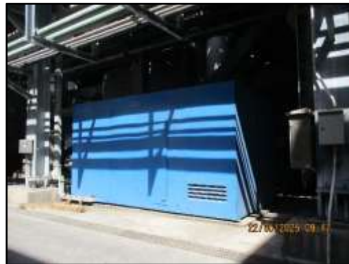
ภาพที่ 2.21 การปิดครอบเครื่องจักรอุปกรณ์ที่มีเสียงดัง
