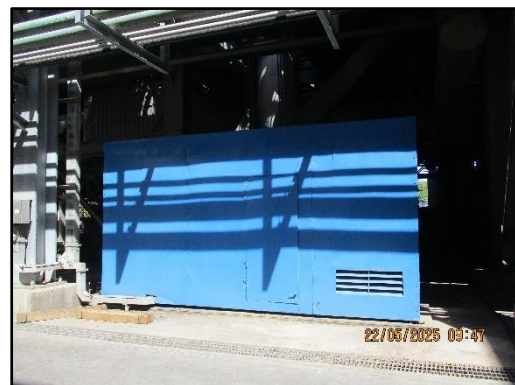
ภาพที่ 3.81 การปิดครอบเครื่องจักรอุปกรณ์ที่มีเสียงดัง
