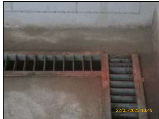
ภาพที่ 2.24 รางรองรับน้ำมันกรณีน้ำมันหกรั่วไหลบริเวณอาคารเก็บรวบรวมน้ำมัน
