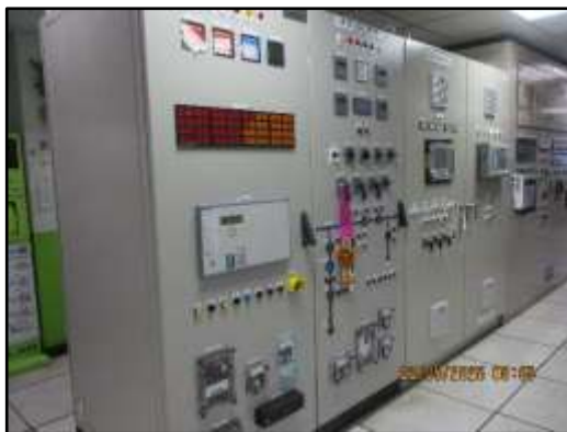
ภาพที่ 2.50 อุปกรณ์ป้องกันกระแสเกิน (Over current relays), อุปกรณ์ป้องกันแรงดันไฟฟ้าสูงเกิน (Over voltage relay), อุปกรณ์ป้องกันไฟฟ้าย้อนกลับ (Reverse power relay), อุปกรณ์ป้องกันการรั่วไหลของแรงดันไฟฟ้า (Ground over voltage relay)
