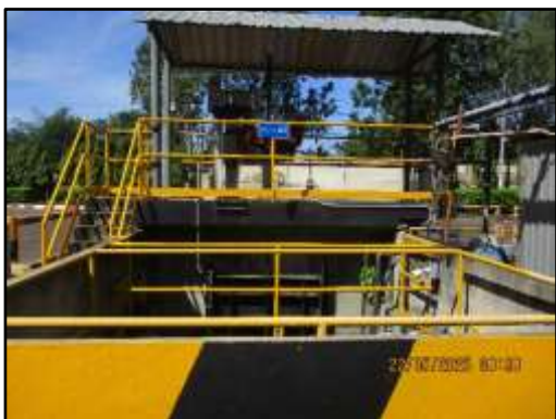
ภาพที่ 2.29 ประตูปะบายน้ำฝน และเครื่องมือตรวจวัดคุณภาพน้ำอย่างต่อเนื่อง (Online)
