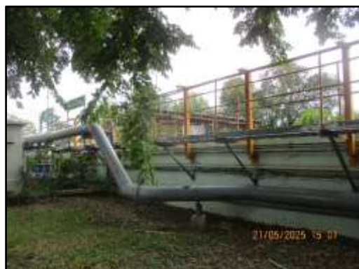
ภาพที่ 2.27 ระบบจ่ายน้ำทิ้ง เครื่องสูบน้ำและท่อส่งน้ำทิ้งภายหลังการบำบัดเพื่อการเกษตร
