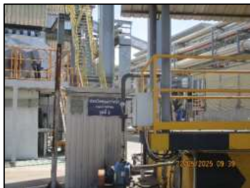
ภาพที่ 2.29 ประตูปะบายน้ำฝน และเครื่องมือตรวจวัดคุณภาพน้ำอย่างต่อเนื่อง (Online)
