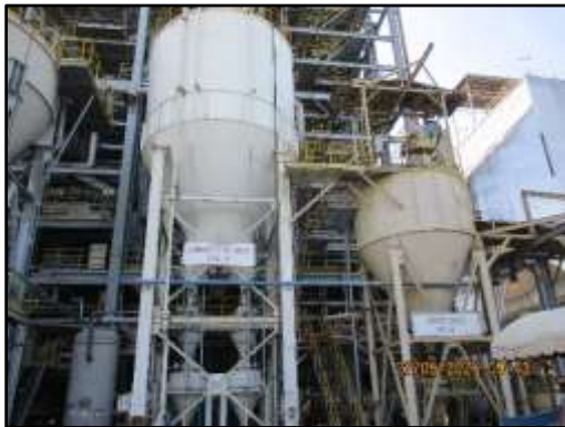
ภาพที่ 2.4 ระบบป้อนหินปูน (Limestone Silo)
