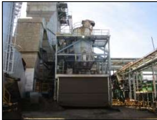
ภาพที่ 2.12 ฉากกั้นป้องกันการฟุ้งกระจายฝุ่นละอองที่ไซโลจ่ายเถ้าลงรถบรรทุก
