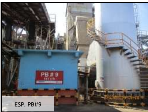
ภาพที่ 2.9 ไซโลกักเก็บเถ้าที่เกิดจากกระบวนการเผาไหม้
