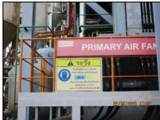
ภาพที่ 2.21 การปิดครอบเครื่องจักรอุปกรณ์ที่มีเสียงดัง
