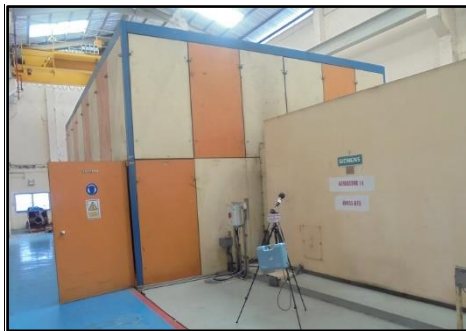
ภาพที่ 3.73 การตรวจวัดระดับเสียงในสถานที่ ทำงานบริเวณอาคารเครื่องกำเนิดไฟฟ้า
