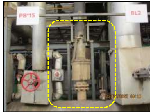
ภาพที่ 2.48 ชุด Bypass valve
