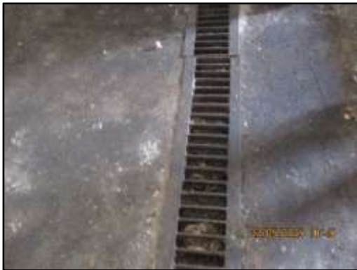
ภาพที่ 2.24 รางรองรับน้ำมันกรณีน้ำมันหกรั่วไหลบริเวณอาคารเก็บรวบรวมน้ำมัน
